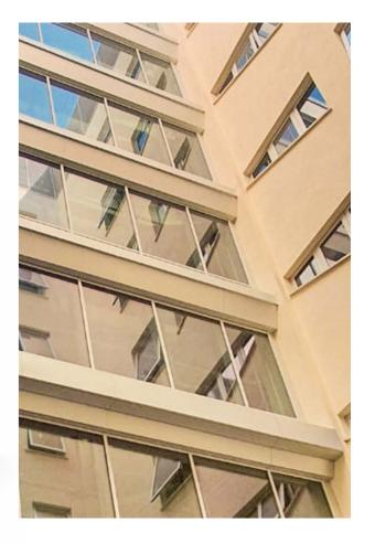
La **facciata continua ALU SYSTEM R5** è strutturata in modo da integrare tutti i sistemi di apertura a battente prodotti dalla Glassfire, ed è composta da montanti e traversi in alluminio, rinforzati ed opportunamente coibentati mediante materiali intumescenti a base di calciosilicati.
