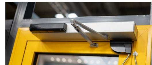
In caso di incendio, è fondamentale che il sistema di azionamento delle porte funzioni correttamente. Il sistema automatizzato è omologato per porte tagliafuoco ad anta, equipaggiato con apriporta elettrico.
